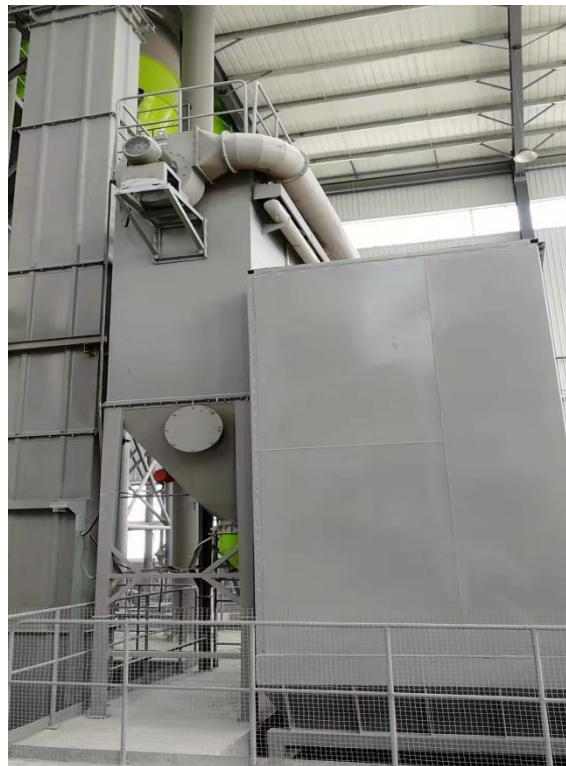
石膏砂浆生产线投料、搅拌工序脉冲布袋除尘器及排气筒
