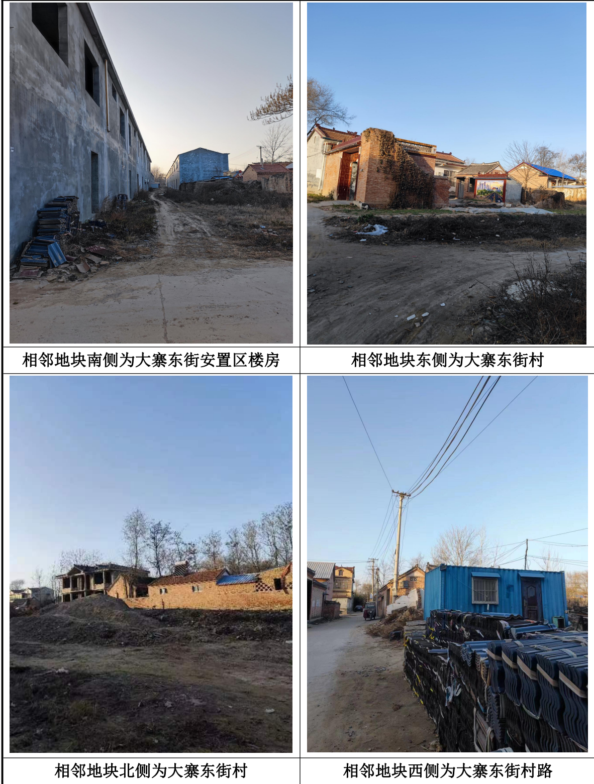
图 3-12 相邻地块现状现场踏勘照片
