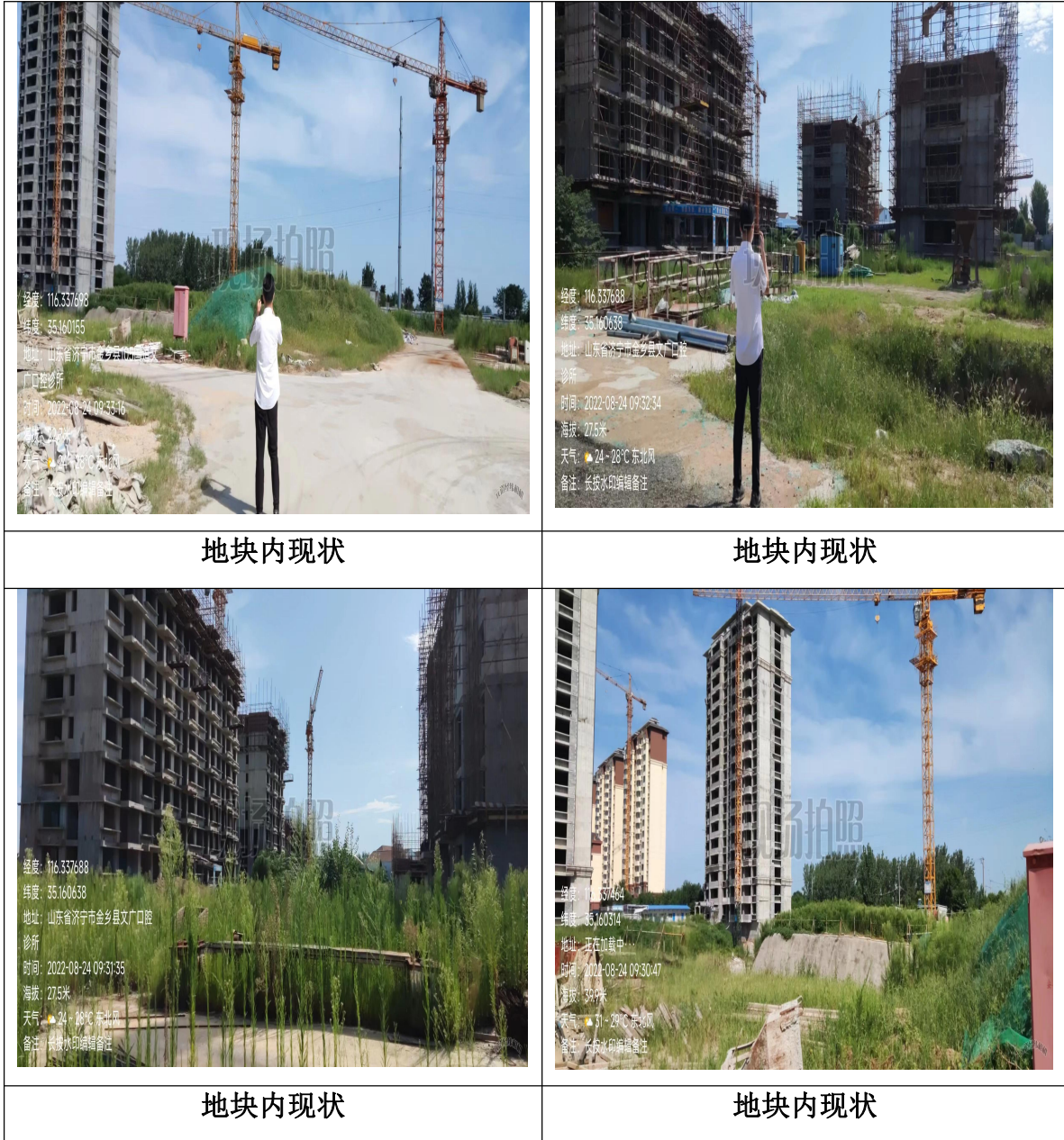
图 3-6 地块内现状现场踏勘照片
