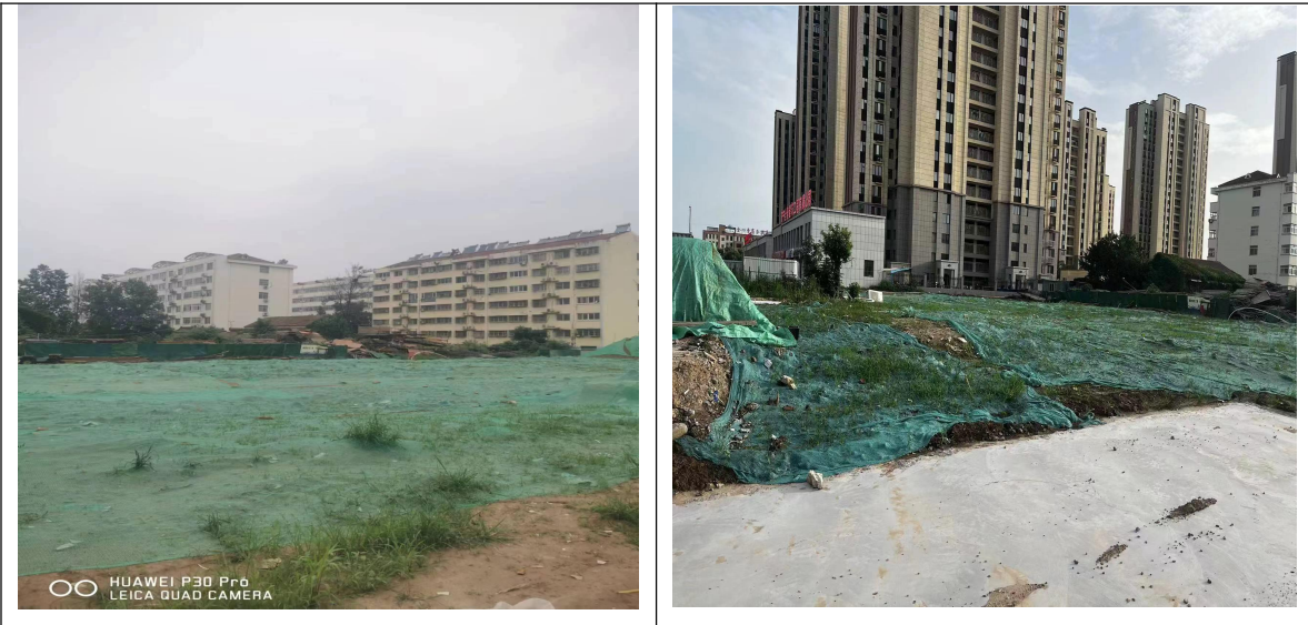
地块内状况，地面使用防尘网覆盖。
