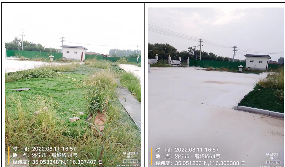
地块一现场照片（消防泵房）
