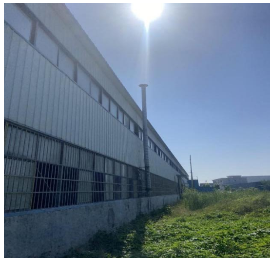
脉冲袋式除尘器 15m 排气筒 P1
