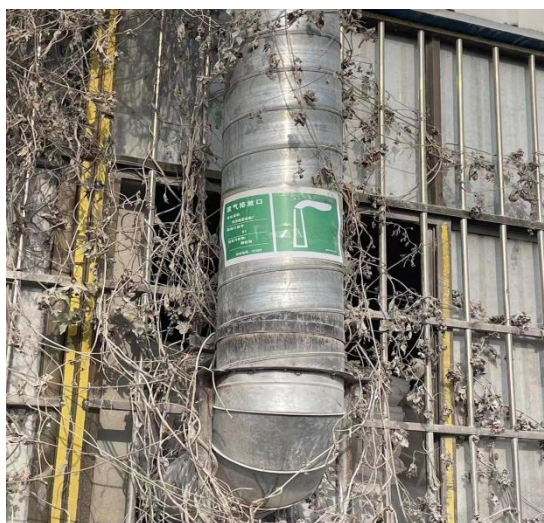
脉冲袋式除尘器 15m 排气筒 P1
