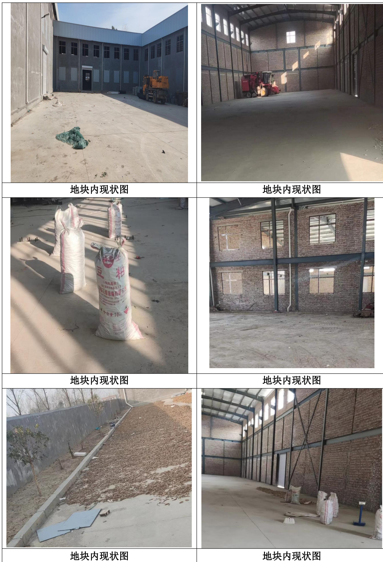
图 5-1 现场踏勘照片
