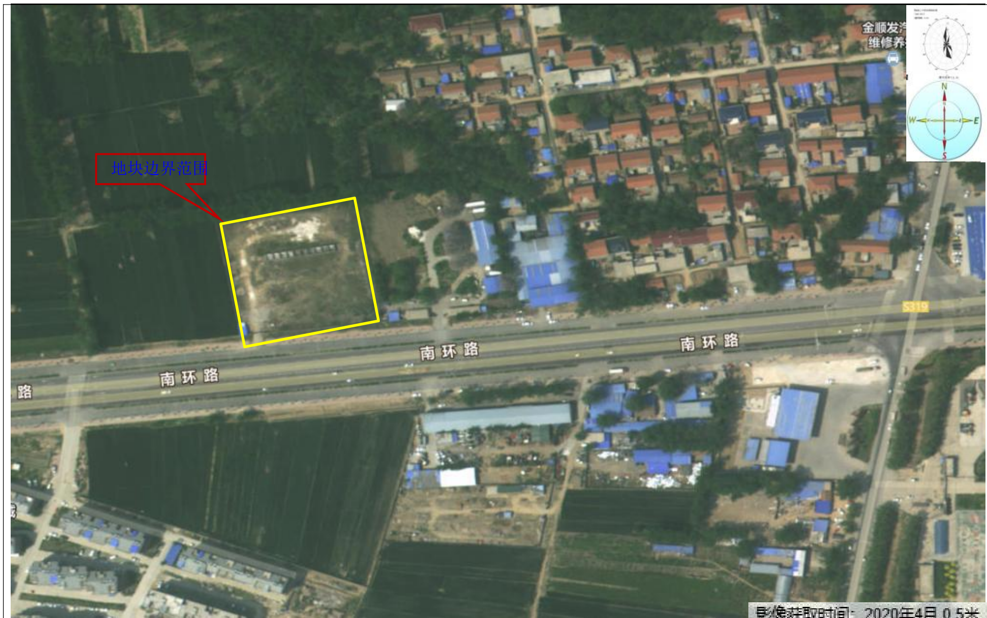
卫星影像拍摄时间：2020年4月，地块内粮食储存仓库进行改建。
