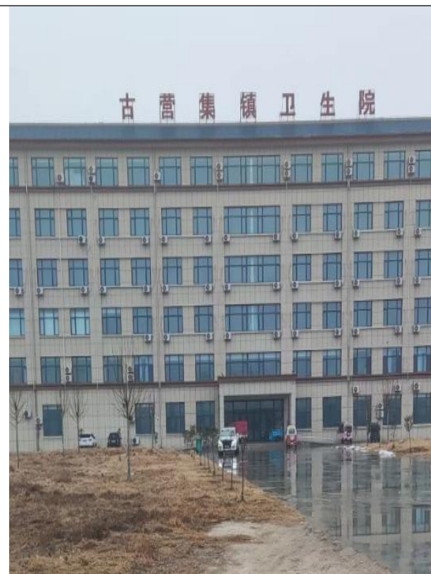
地块南侧古营集卫生院综合楼
