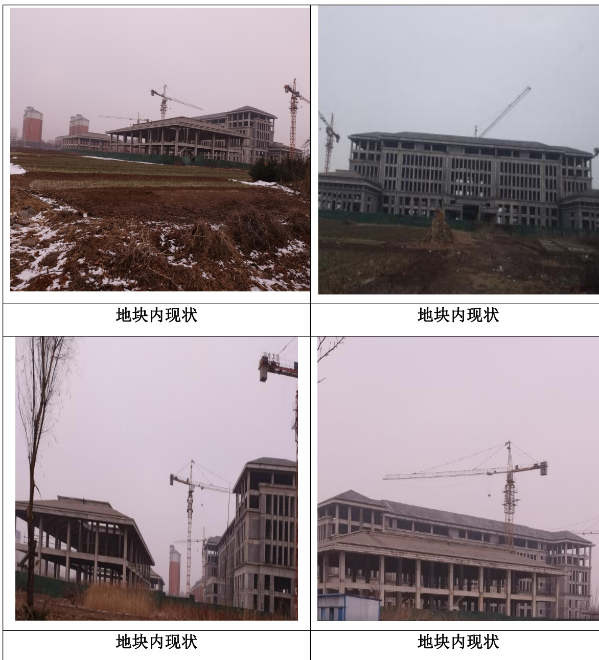
图 3-6 地块内现状现场踏勘照片
