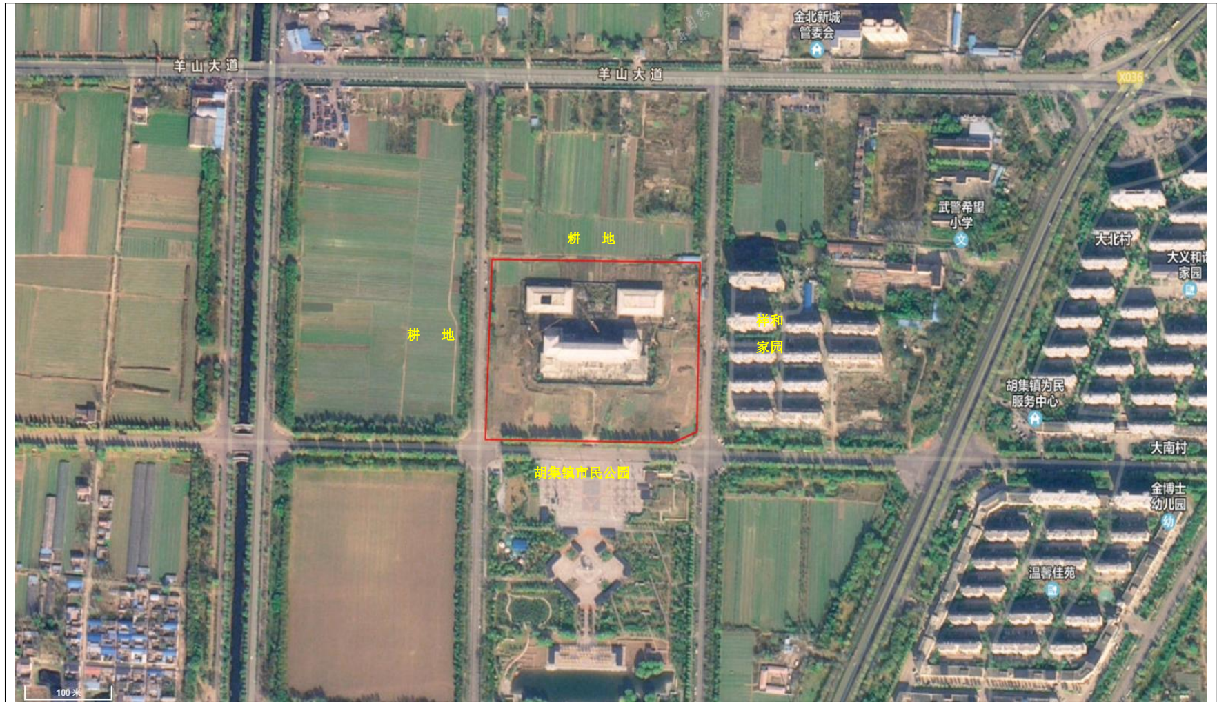
卫星影像时间：2023年11月。相邻地块西侧、北侧为耕地，东侧为祥和家园，南侧为市民公园。
