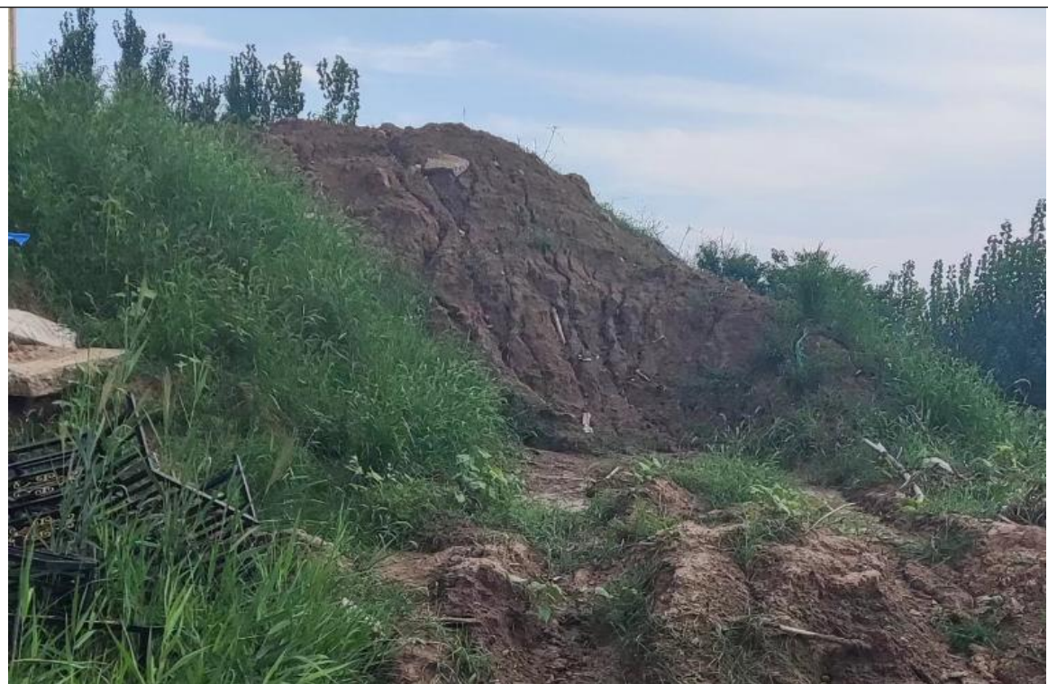
图 5-1 弃土临时堆放区
